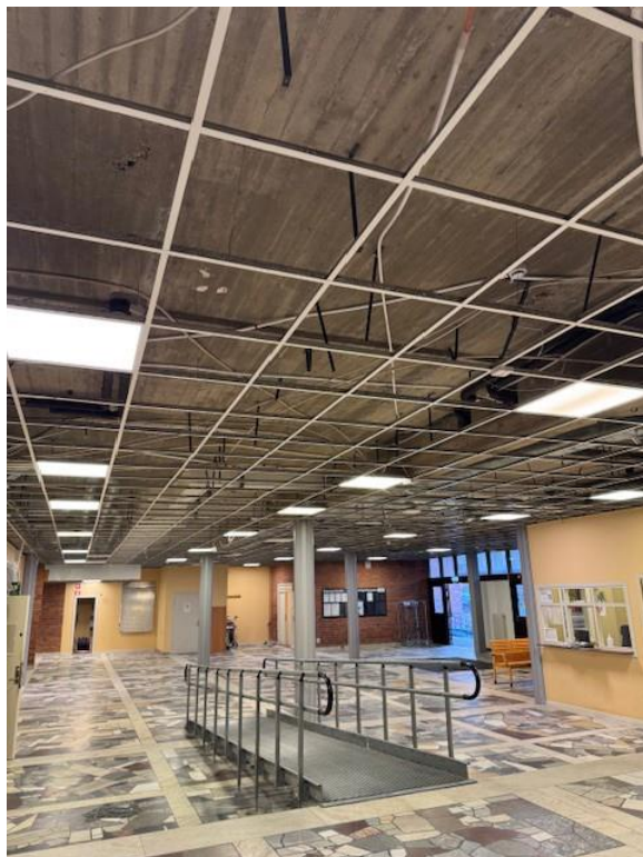
Undertaksplattor nedtagna för säkerställande av projektering rördragning.
